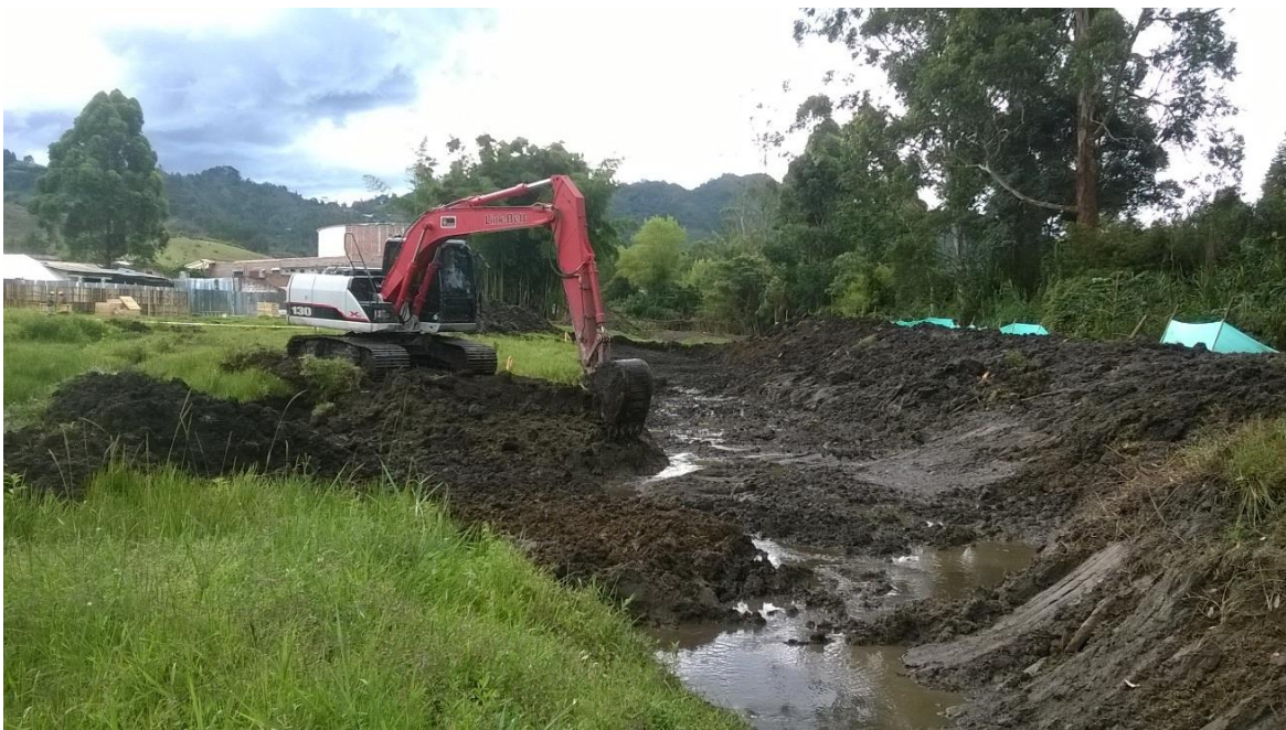
Fotografía 24. Ejecución trabajos de descapote en proyecto La Colina.
