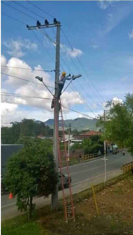
Fotografía 14. Instalación luminarias alumbrado público sobre calle 27.
