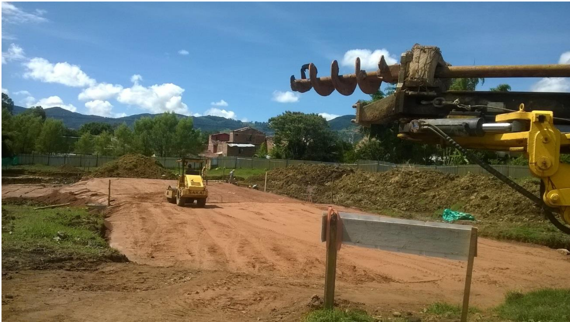
Fotografía 25. Ejecución llenos para soportar edificaciones.
